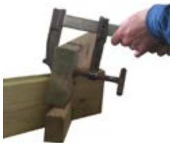
Loose board • Tabla suelta • Madrier voilé • Loses Brett • Tavola libera • Losse plank • Tábua solta
