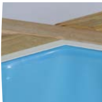
Tense the liner well at the corners Tense bien el liner en las esquinas Tendez bien le liner dans les angles
